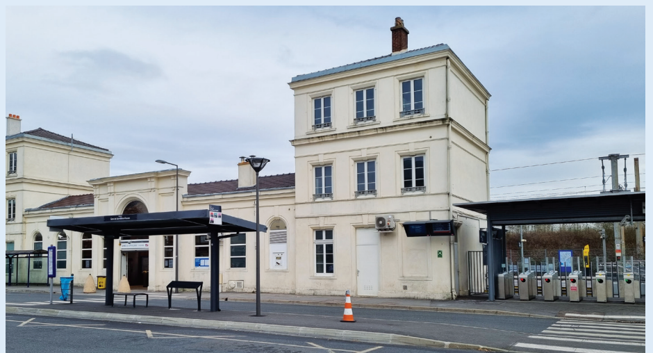
La gare de Surveilliers-Fosses : les dysfonctionnements du RER D sont un souci constant pour de nombreux habitants et pour les élus.
